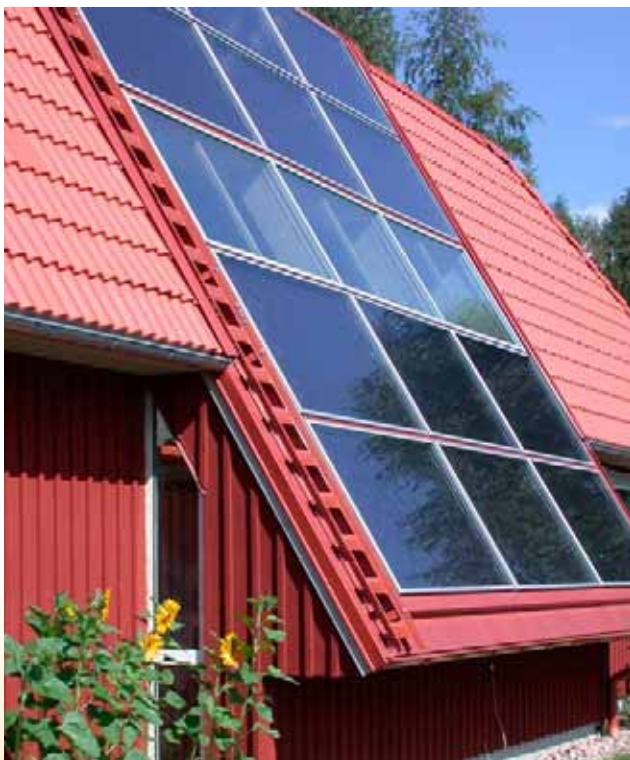
Svesols nya hus värms först och främst av solfångare. Ett säsongsvärmelager under huset lagrar överskottsvarmen från sommaren vilken hämtas upp igen under höst och vinter. När lagret börjar tryta toppar vi med värme från pelletspanna och vattenmantlad pelletskamin.
